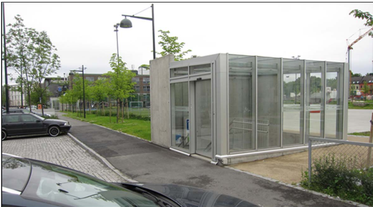
Figur 2: Eksempel på trappehus i glass (P-hus Finalebanen, Trondheim)
